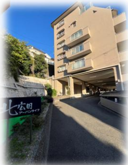
大規模修繕工事了 マンション外壁もきれいです!!
